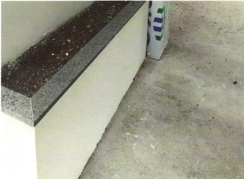
Foto 27 –SOLEIRA EM MÁRMORE, LARGURA 15 CM, ESPESSURA 2,0 CM. AF_09/2020
