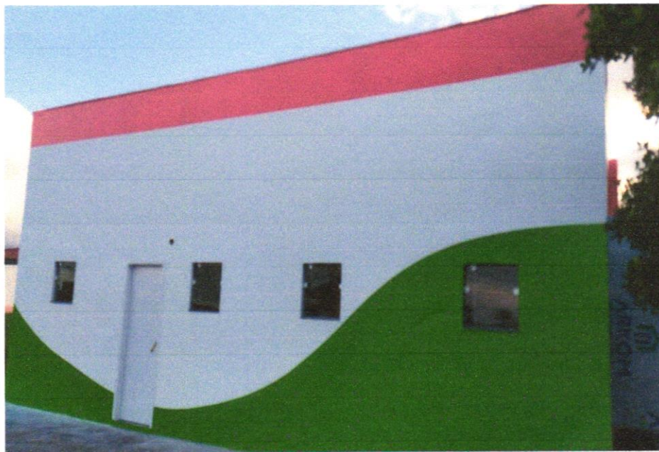
FOTO 01 – APLICAÇÃO MANUAL DE PINTURA COM TINTA LÁTEX ACRÍLICA EM PAREDES, DUAS DEMÃOS. AF_06/2014
