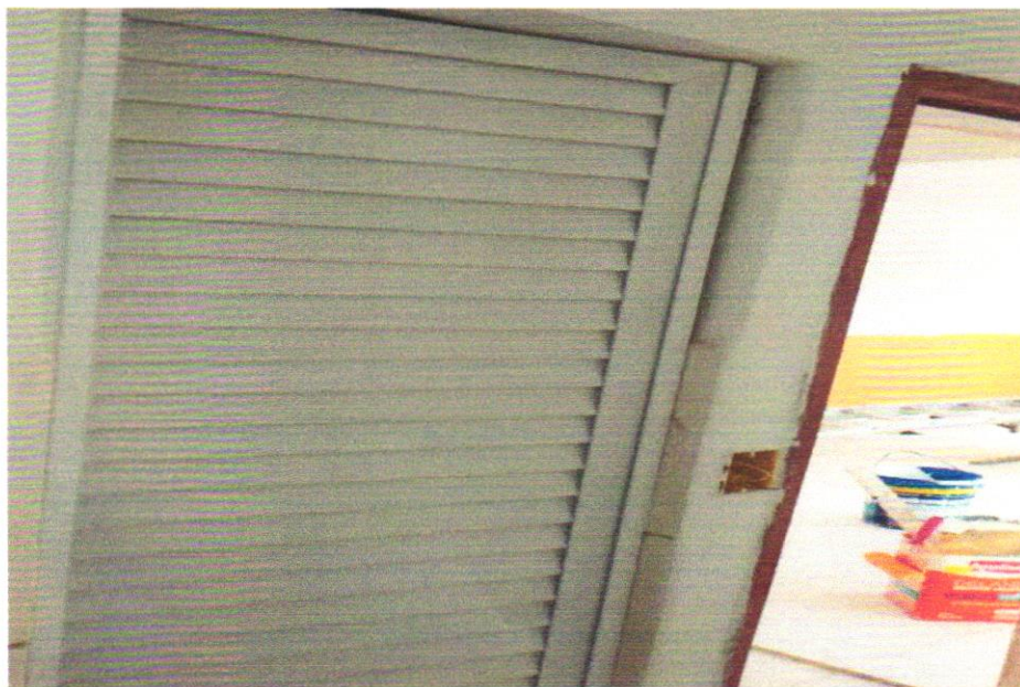
Foto 13 PORTA EM ALUMÍNIO DE ABRIR TIPO VENEZIANA COM GUARNIÇÃO, FIXAÇÃO COM PARAFUSOS - FORNECIMENTO E INSTALAÇÃO. AF_12/2019
