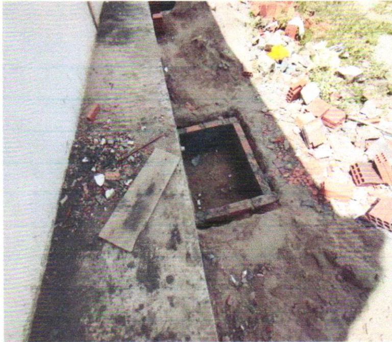
Foto 17 – caixa de inspeção
