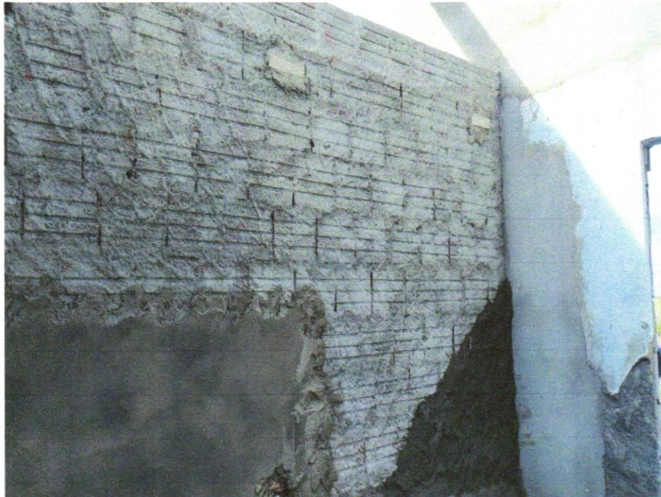
Foto 29- CHAPISCO APLICADO EM ALVENARIA (COM PRESENÇA DE VÃOS) E ESTRUTURAS DE CONCRETO DE FACHADA, COM EQUIPAMENTO DE PROJEÇÃO. ARGAMASSA TRAÇO 1:3 COM PREPARO EM BETONEIRA 400 L. AF_06/2014
