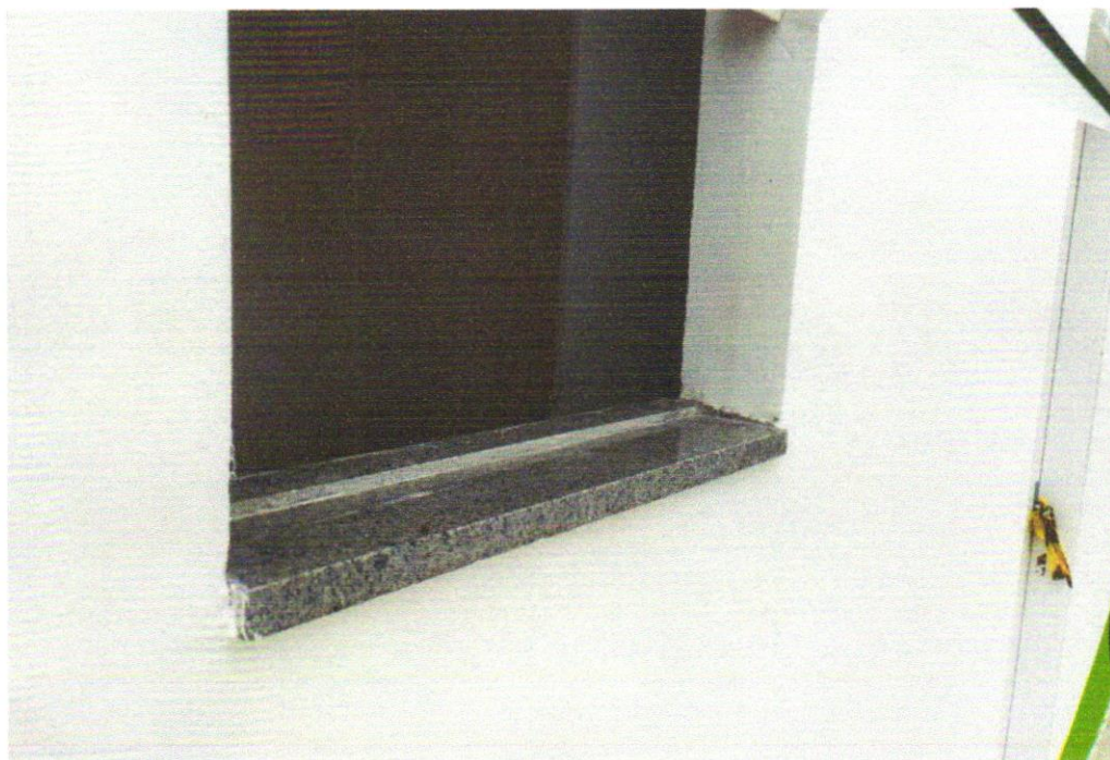
Foto 22 - PEITORIL LINEAR EM GRANITO OU MÁRMORE, L = 15CM, COMPRIMENTO DE ATÉ 2M, ASSENTADO COM ARGAMASSA 1:6 COM ADITIVO. AF_11/2020
