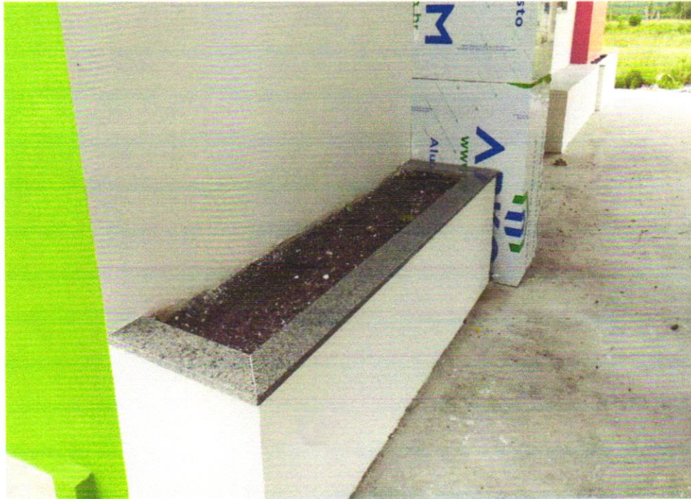
Foto 07– Fornecimento e espalhamento de terra vegetal preparada
