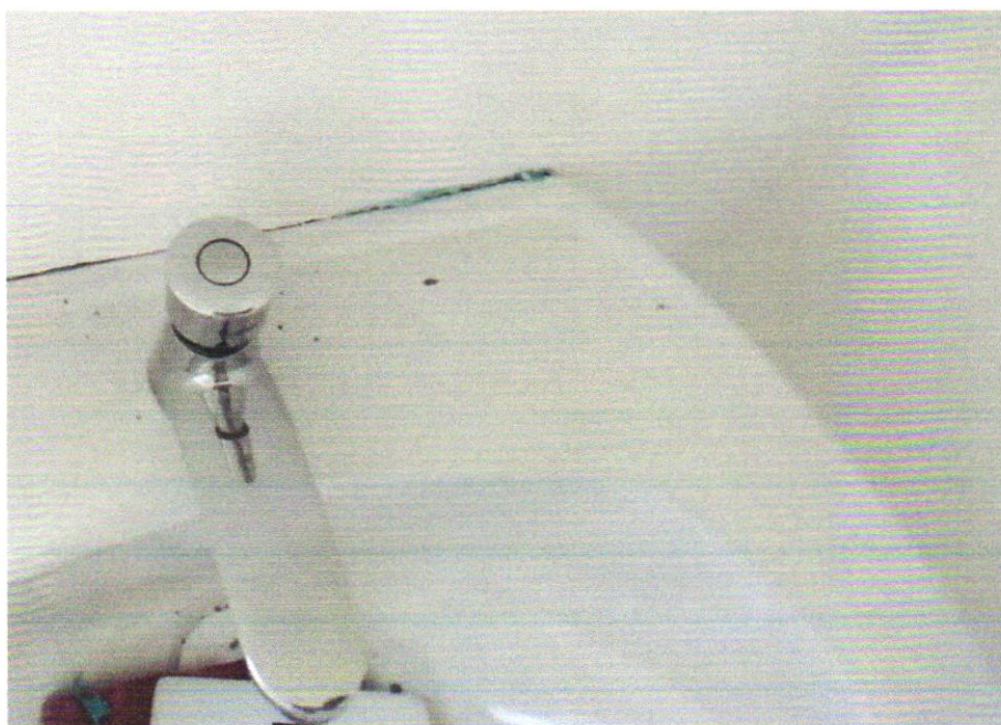
Foto 14 - TORNEIRA CROMADA 1/2" OU 3/4" PARA TANQUE, PADRÃO POPULAR - FORNECIMENTO E INSTALAÇÃO. AF_01/2020
