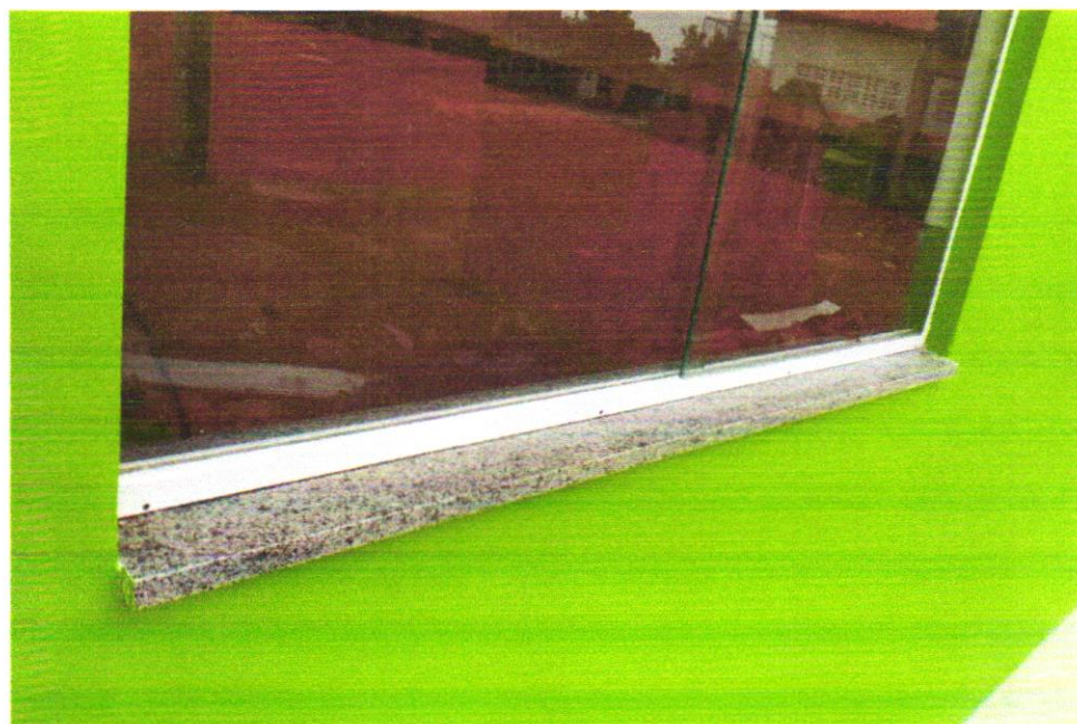
Foto 20 - PEITORIL LINEAR EM GRANITO OU MÁRMORE, L = 15CM, COMPRIMENTO DE ATÉ 2M, ASSENTADO COM ARGAMASSA 1:6 COM ADITIVO. AF_11/2020
