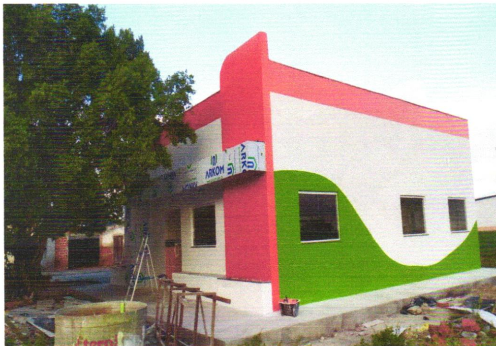
FOTO 03 - APLICAÇÃO MANUAL DE PINTURA COM TINTA LÁTEX ACRÍLICA EM PAREDES, DUAS DEMÃOS. AF_06/2014
