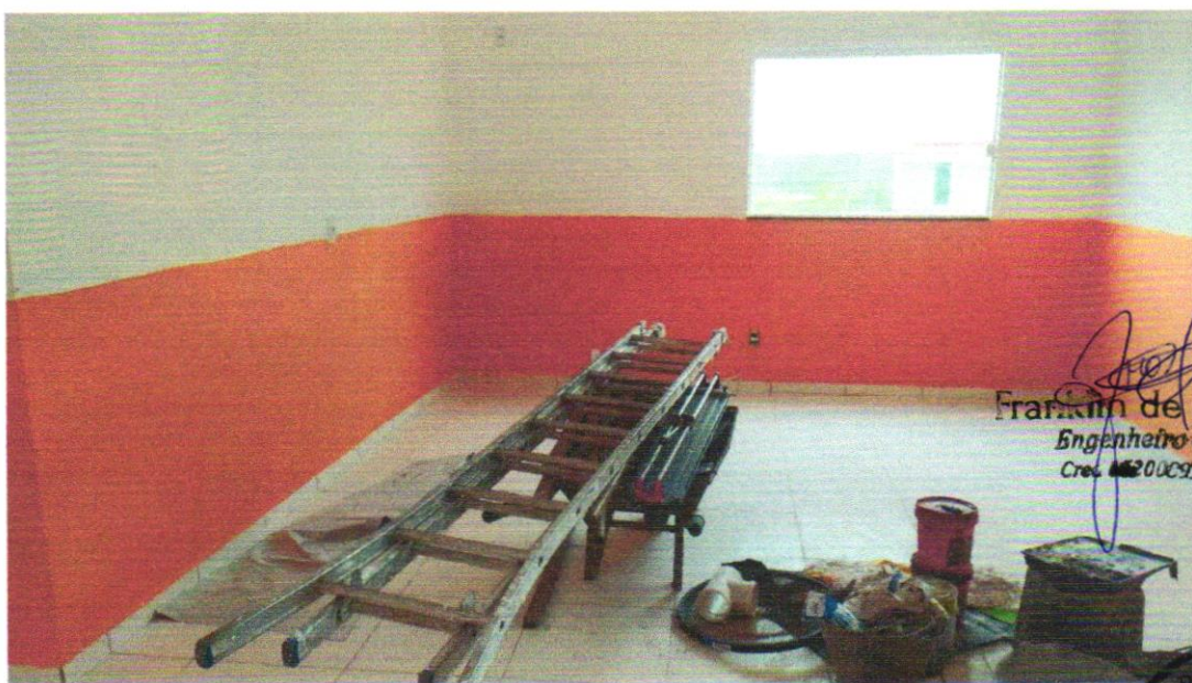
FOTO 10 – APLICAÇÃO MANUAL DE PINTURA COM TINTA LÁTEX ACRÍLICA EM PAREDES, DUAS DEMÃOS. AF_06/2014
