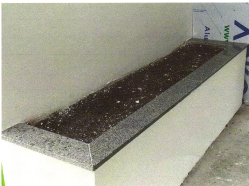
Foto 38 - SOLEIRA EM MÁRMORE, LARGURA 15 CM, ESPESSURA 2,0 CM. AF_09/2020
