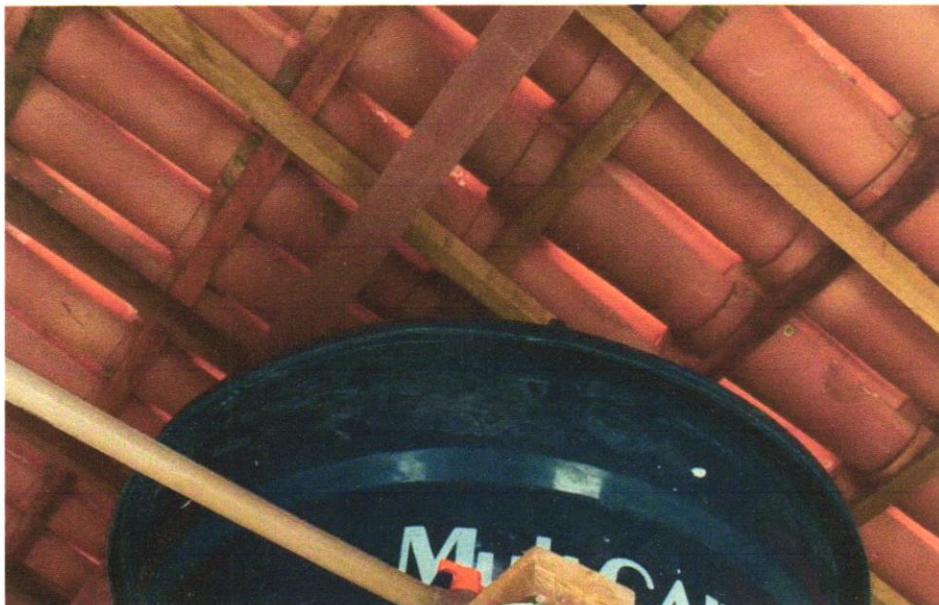
Foto 37- CAIXA D'ÁGUA EM POLIÉSTER REFORÇADO COM FIBRA DE VIDRO, 500 LITROS - FORNECIMENTO E INSTALAÇÃO. AF_06/2021 e REGISTRO DE ESFERA, PVC, SOLDÁVEL, COM VOLANTE, DN 25 MM - FORNECIMENTO E INSTALAÇÃO. AF_08/2021
