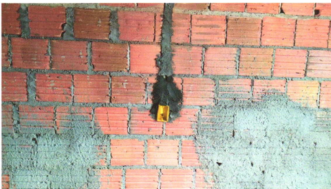
FOTO 33 - Alvenaria de vedação de blocos
