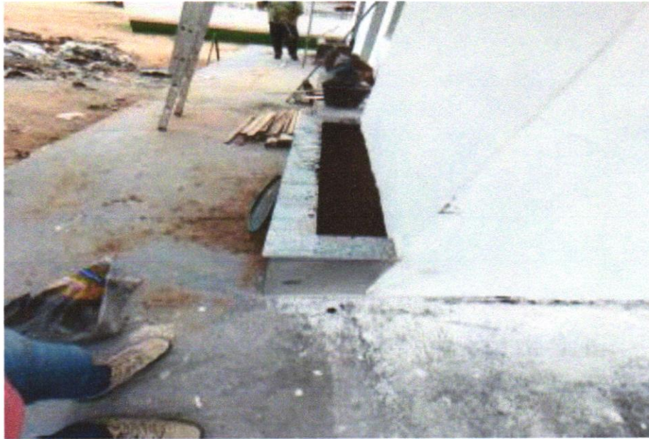
FOTO 05 – SOLEIRA EM MÁRMORE, LARGURA 15 CM, ESPESSURA 2,0 CM. AF_09/2020
